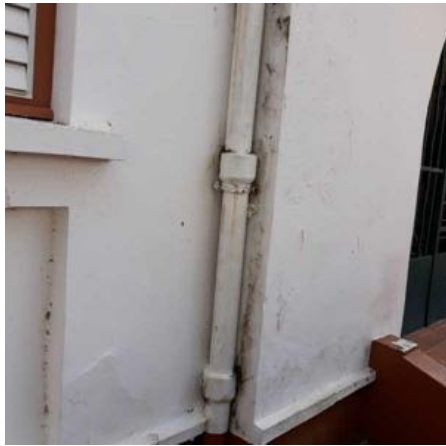
Prélèvement - P622 : Mairie des Trois-Ilets / Bat Ancienne Mairie / Extérieur / Façades - Conduit d'eau pluviale - EP- (Présence d'amiante)
